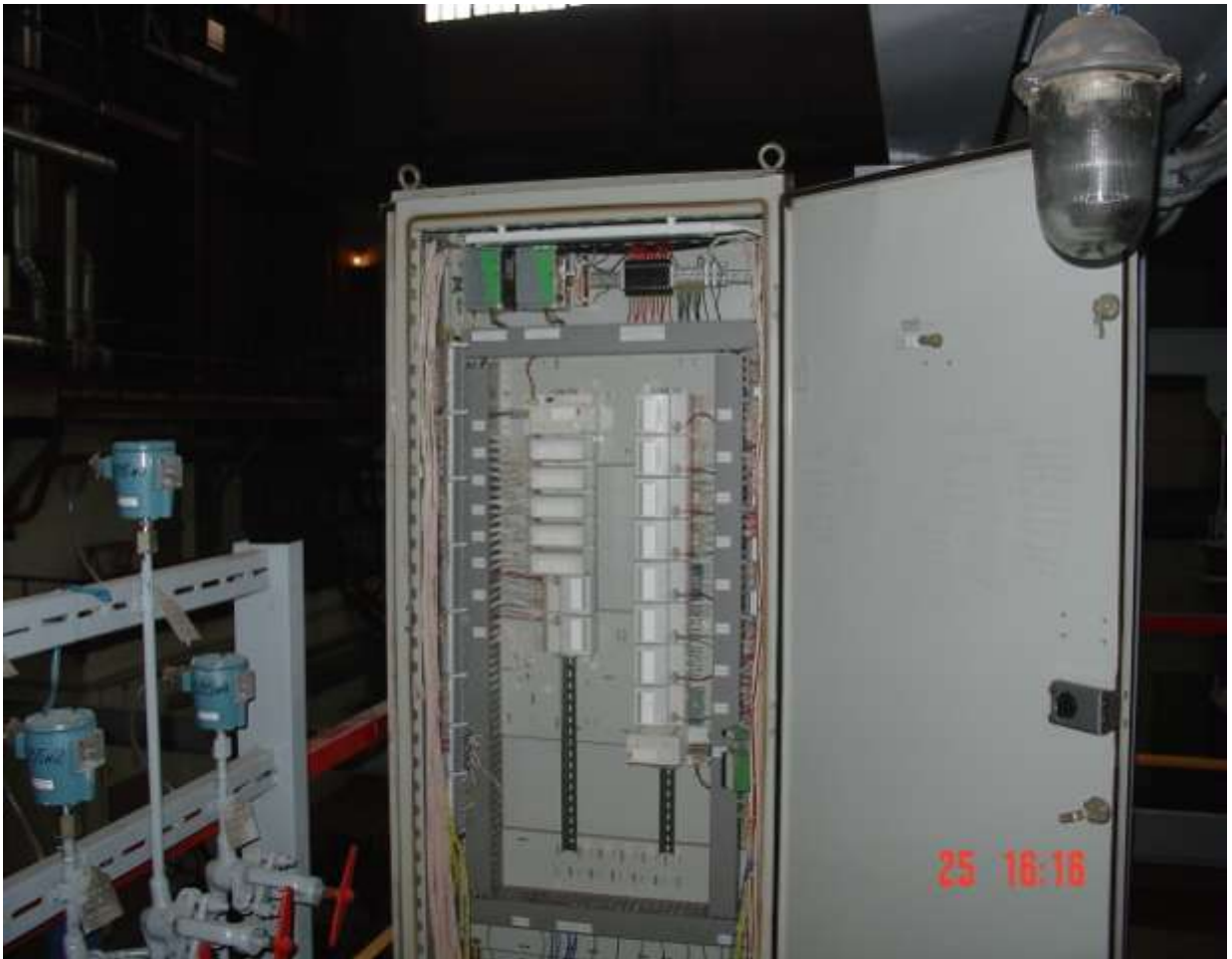
Рис. 1.4. Шкаф с модулями УСО в распределенной АСУ ТП.
