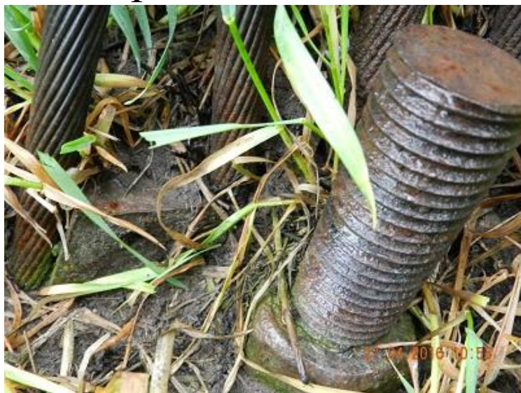
Навалы грунта на клин-коуши оттяжек опоры № 103
