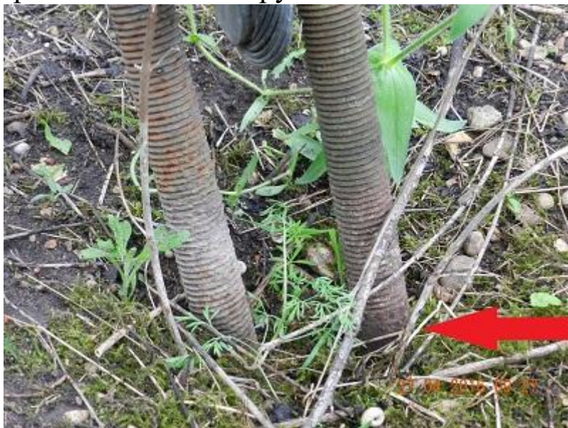
U-образные болты оттяжек опоры №20
