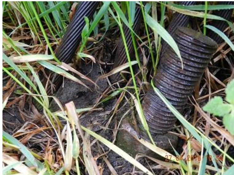
Навалы грунта на клин-коуши оттяжек опоры № 103
