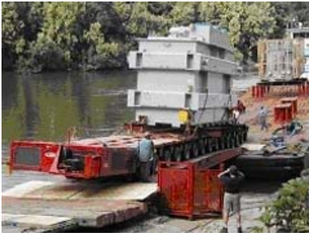
До испытаний before test
