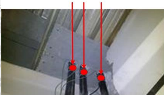
Установка температурных датчиков на КЛ 35 кВ
