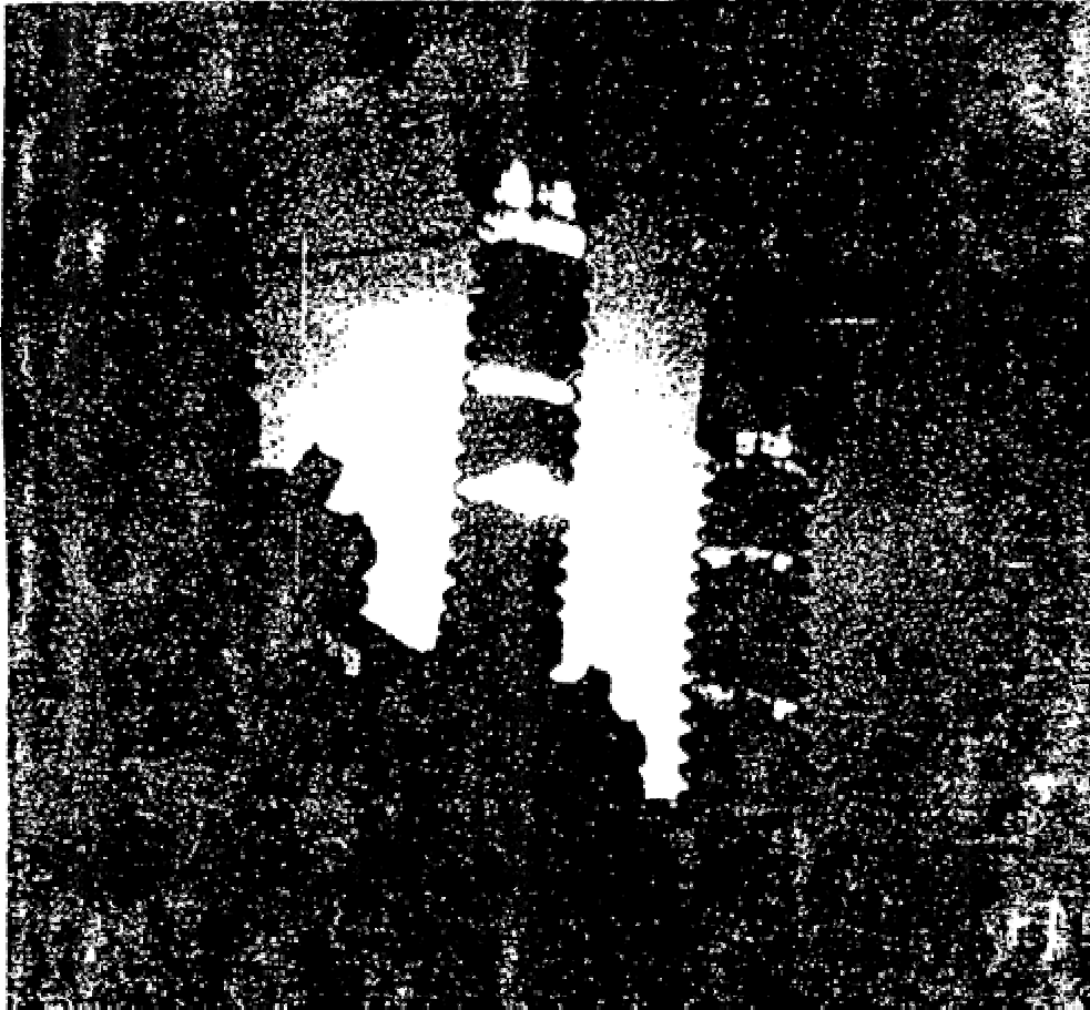
Рис.П.1.0-17. Термограмма вводов силового трансформатора (белые участки на поверхности покрышек - места возникновения короны)
